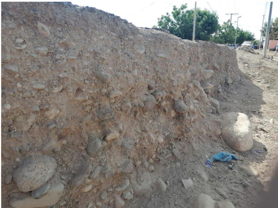
Figure 29 : Important remblai dans le quartier Quarawil- Pompage, comblant une dépression d'oued (Aliel Consulting)
